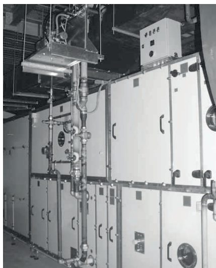
Система насосов высокого давления
